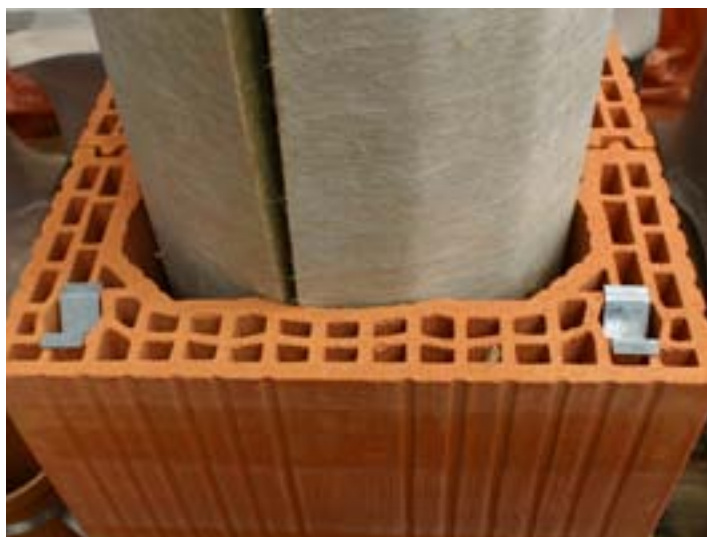
Umístění zaslepujících plíšků
